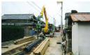
PALSONIC-4B 山口県北門下区管下下水道/公共下水道掘削工事 機体幅4.2m・長さ5.0m 作業径1.5m・2.0m 土質 砂・砂・片巻 5
