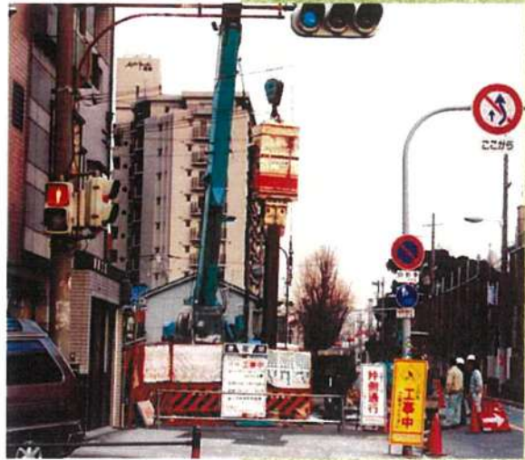
市街地でのH鋼杭打込み
