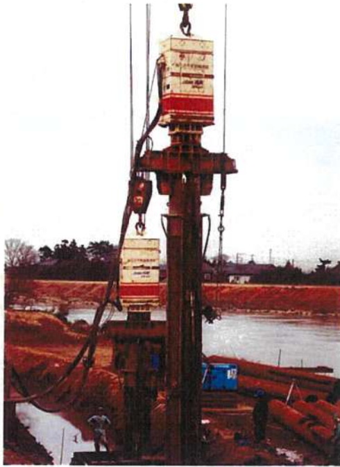
鋼管矢板(φ800×15m)の打込み(鋼管チャック装備)
