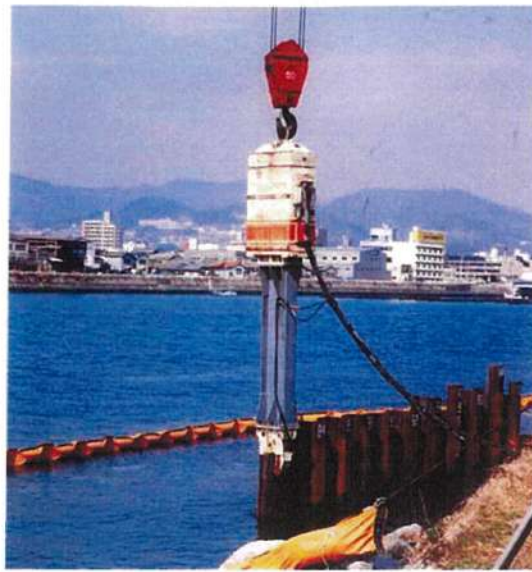
鋼矢板の水中打込み(ヤットコアアダプタ装着)
