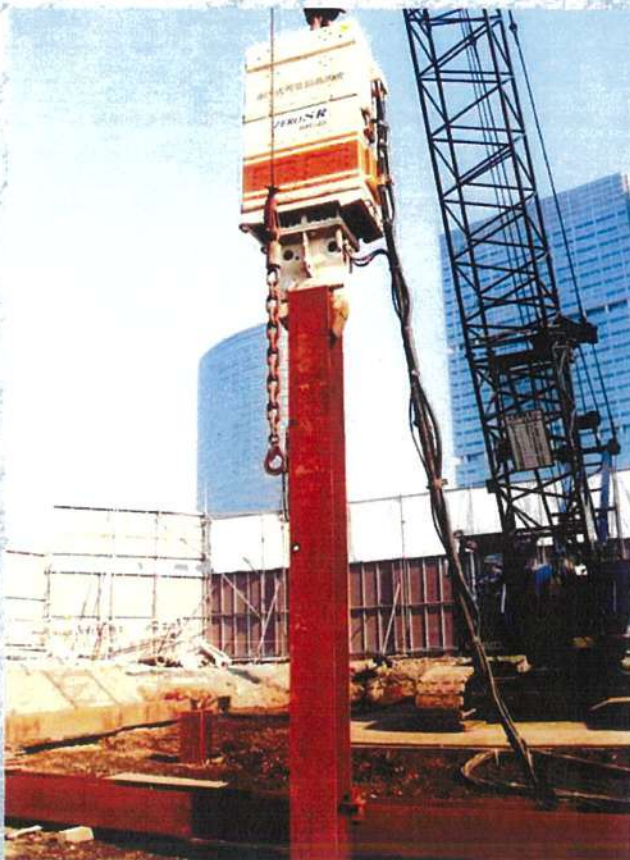
品川駅前でのH鋼杭打込み
